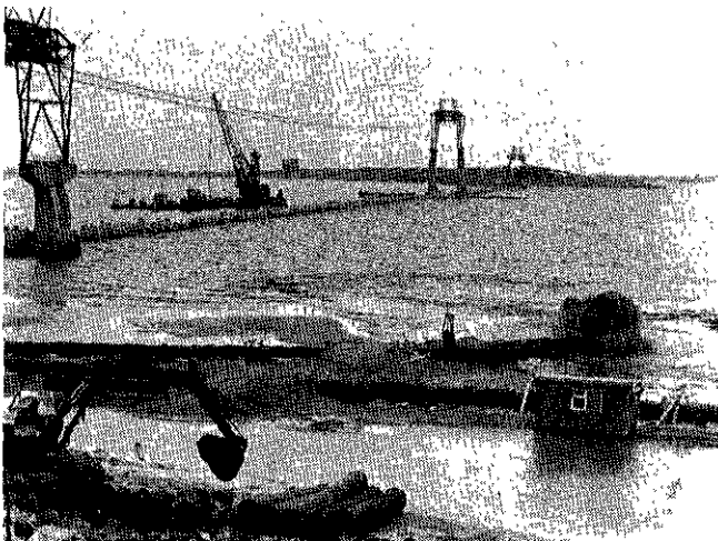
Zandsputten bij de opbouw van het dijklichaam in het Rak van Scheelhoek
